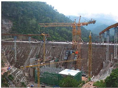
ラオス・ナムニアップダム現場 (2017年5月23日撮影)
