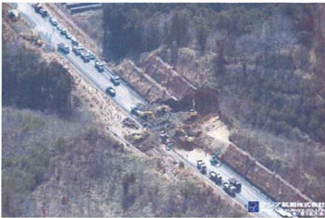
被災した常磐自動車道（福島県相馬市）
