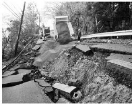
穴水町川尻地内での、向出組（石川県加賀市）による道路啓開作業（10月11日／全国建設業協会提供）
