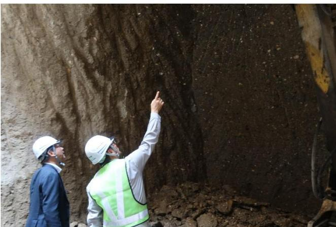
現場では、管径5.5mの水圧鉄管を1門設置することとしており、垂直階段で移動が可能な仮締切を上流側に設置するなど工夫を凝らして施工中で、今回は削孔中の現場にも入らせていただきました。切羽のコンクリートは鎧畑ダムでボーリング調査を行った際と同様に密実かつ堅固で、コンクリートの長期強度の発現を強く感じました。
