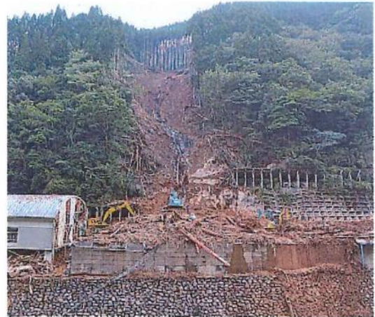
土砂崩れが発生した現場（9日）
