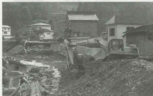
銅山川の勢いで洗掘された河川と道路の応急復旧
