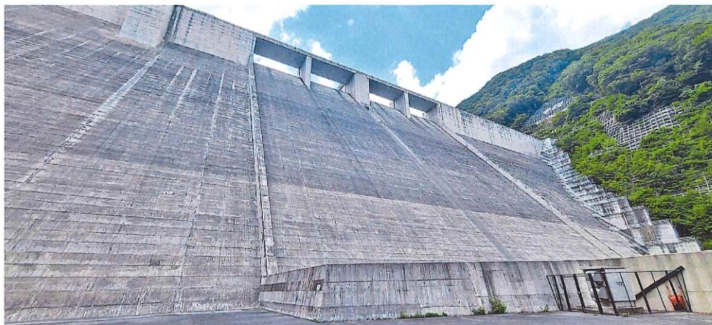
発電設備の新設に伴い再整備が計画される湯西川ダム
