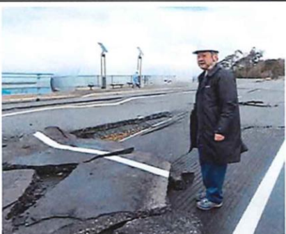
珠洲市の国道249号で被災状況を確認する足立参院議員
